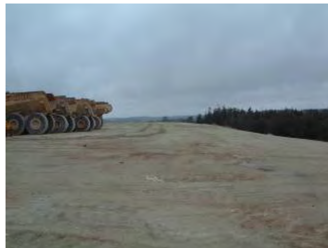
Lissage du dôme avant la pose du géotextile
