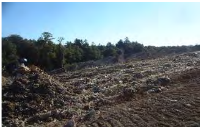
Nivellement général (formation d'un dôme régulier)
