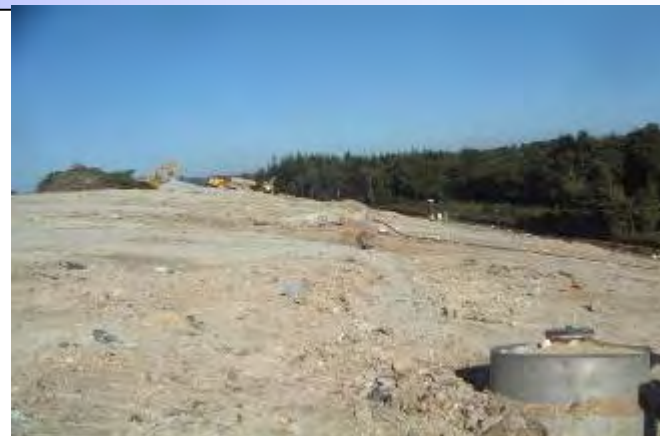
Recouvrement de matériaux argileux sur 30 cm
