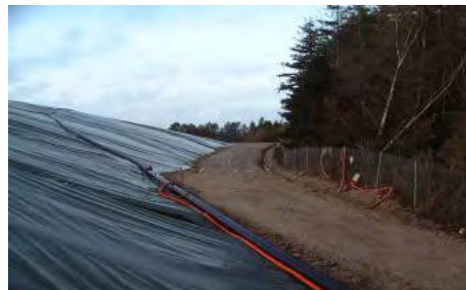
Piste périphérique (accès aux équipements biogaz...)
