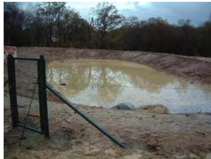
Bassin de collecte des eaux pluviales
