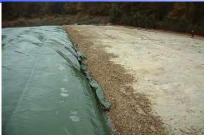
Pose et ancrage du géotextile
